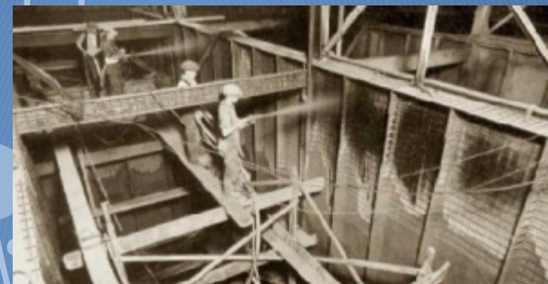
Торкретирование - метод нанесения
